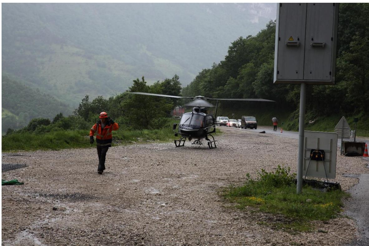
RD 518. Commune d'Echevis, sans interrompre la circulation, sauf par quelques coupures de 10 à 20 minutes, la mise en place des filets anti chutes de pierres se fait avec l'aide de l'hélicoptère.
