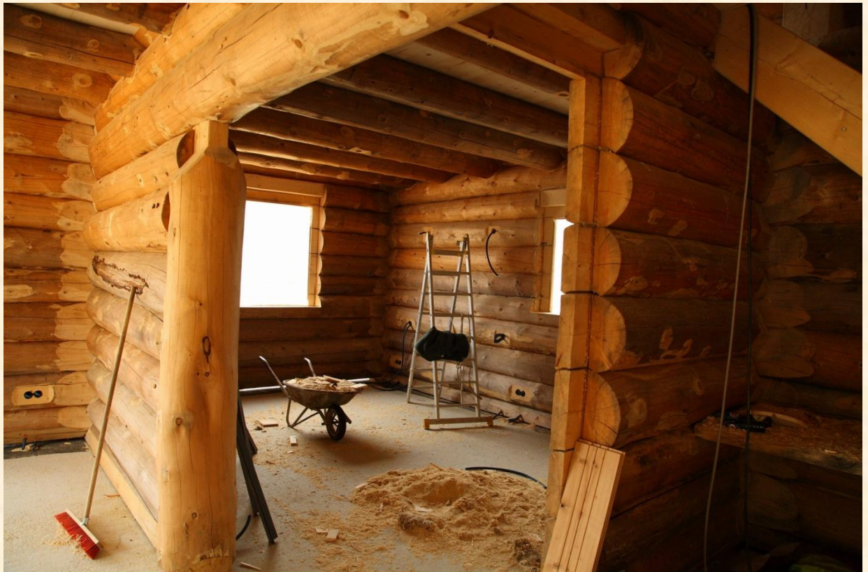
Maison FUSTE en construction
