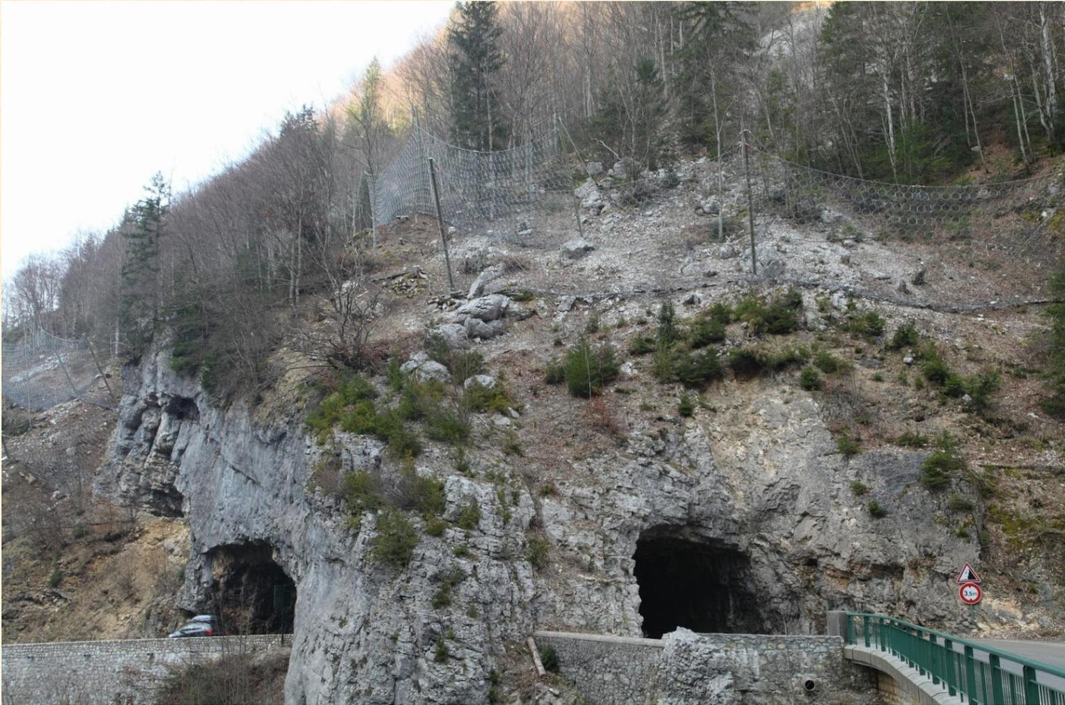
Vers le pont de Goule noire les travaux sont en cours pour la sécurité de tous. Les opérations de purge de falaise, de pose de grillage et d'écrans pare-blocs.
