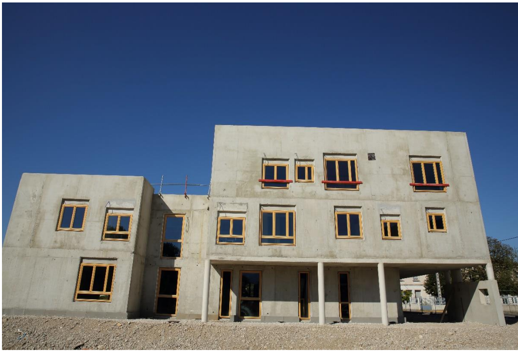
8 septembre 2020, les fenêtres sont posées
