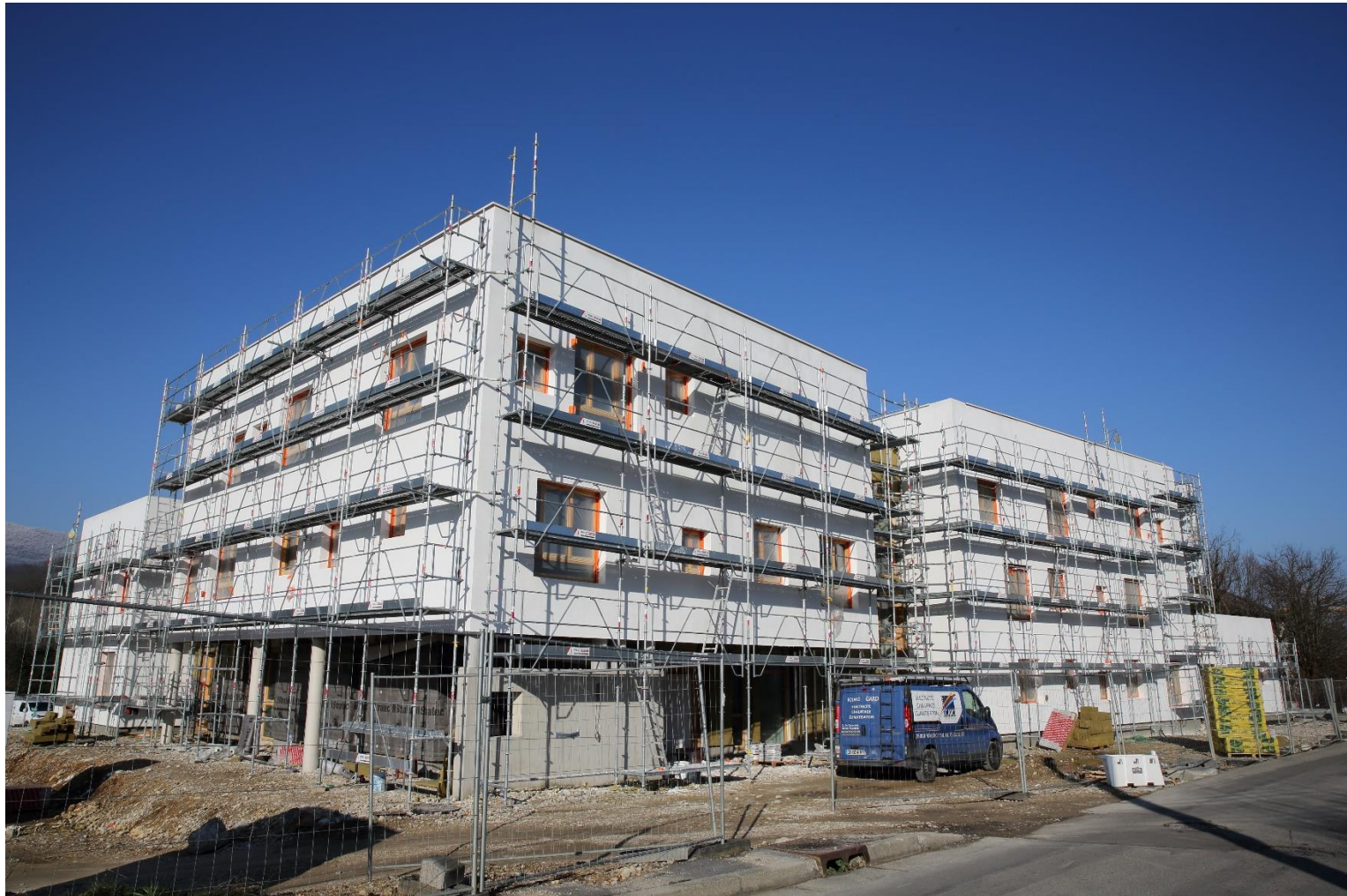
8 janvier 2021. Un soleil complice permet cette belle photographie, qui donne une idée du chantier en cours.
