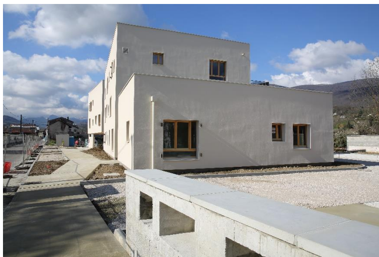
7 avril 2021 Les travaux avancent rapidement.
