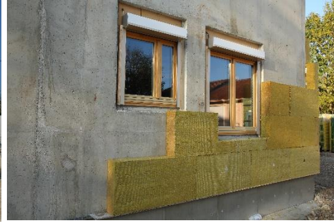
29 septembre isolation des murs
