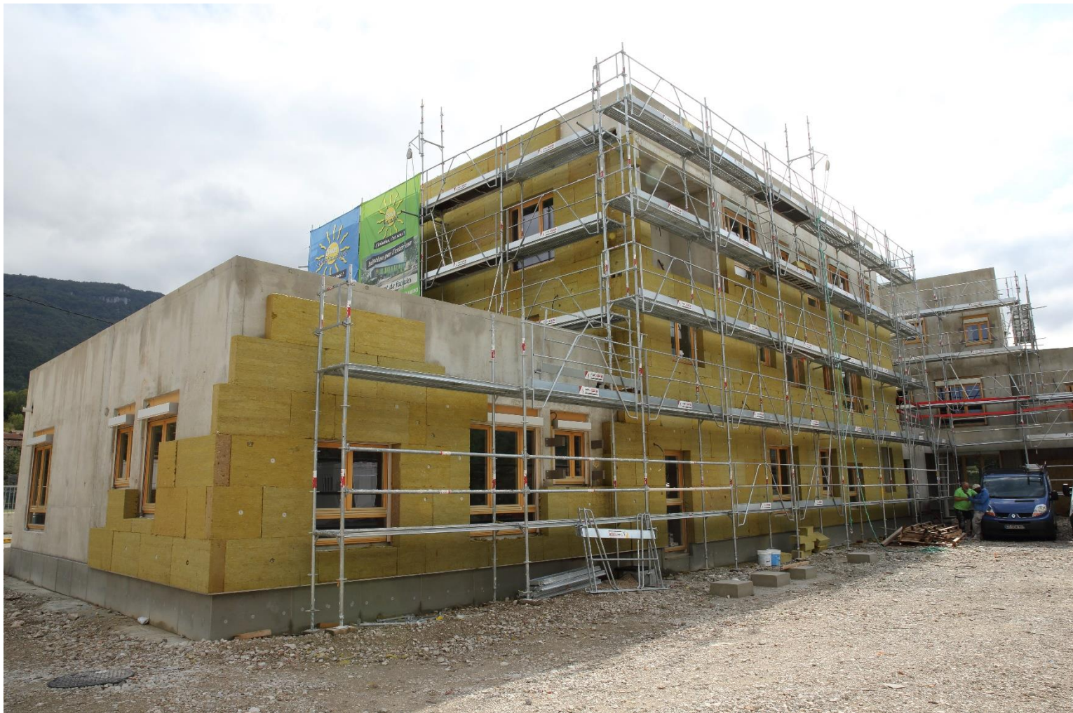
29 septembre. Echafaudages et isolation par l'extérieur. 'Côté cour'
