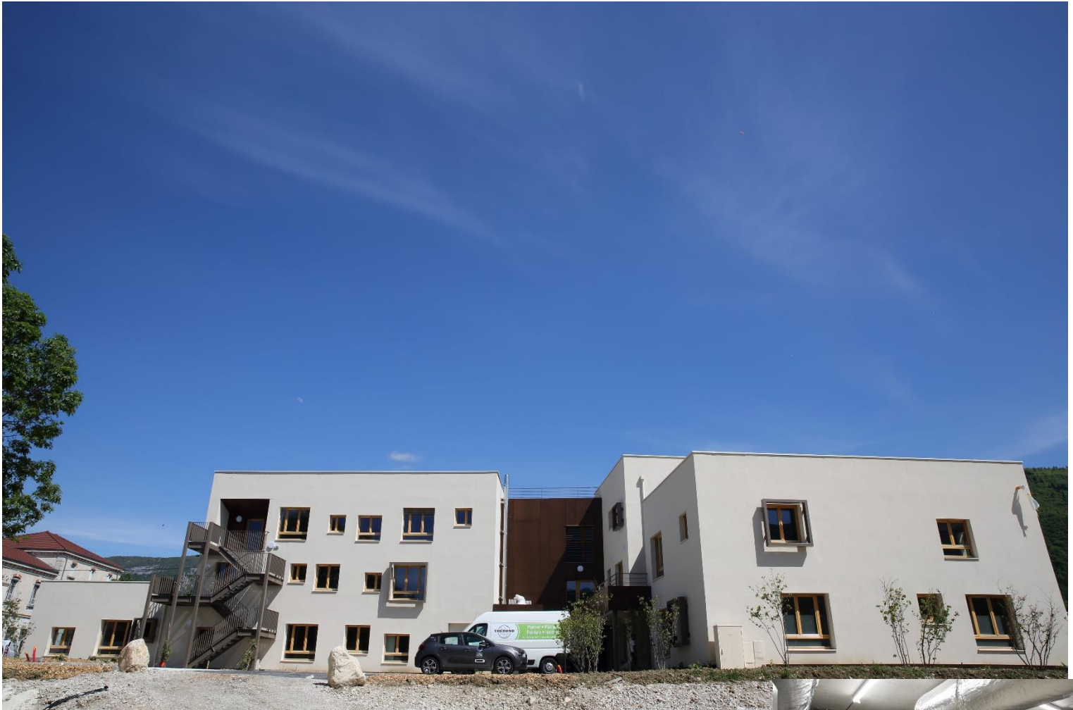
17 mai 2021 Vue d'ensemble de la façade ouest.
