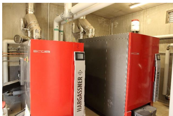
Autrans Chaudières 2 et 1.
