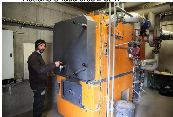
Méaudre la chaudière bois déchiqueté
