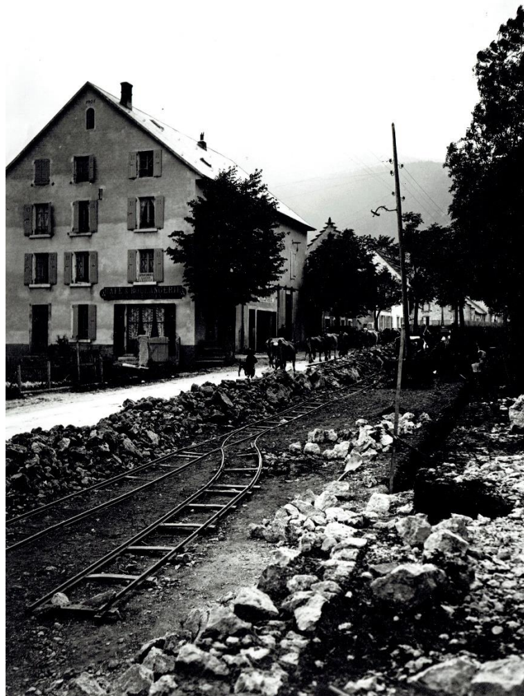
Construction du tram à Lans-en-Vercors
